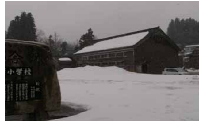
増加している空きビル、空き家 Increasing vacant buildings and homes
